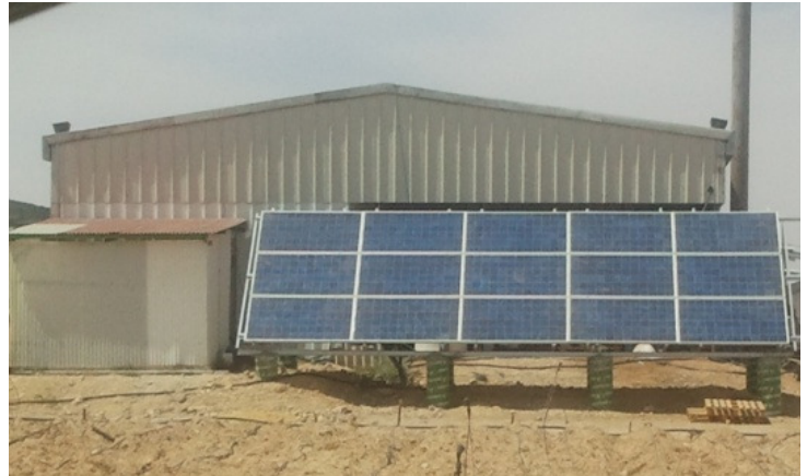
תמונה 1 : מערכת התאים הסולאריים להפעלת מערכת הנופלטריציה לטיפול במים בתחנת הניסויים יאיר.
