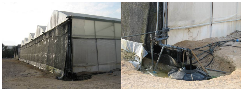
תמונה 1: מערכת הצינון באמצעות 4 רשתות צמודות בקיר הצפוני ומערכת איסוף מי הצינון (מימין)
